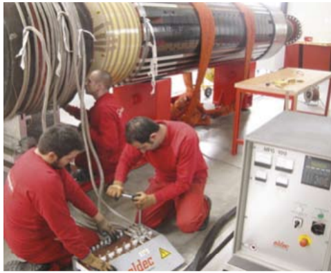
Aufziehen einer Kappe auf einen Rotor.
