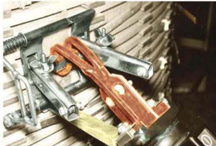
▲ Bild 4: Löten der auf Stumpfstoß vorbereiteten Kupferdrähte mit anliegendem Induktor in 2 bis 3s
